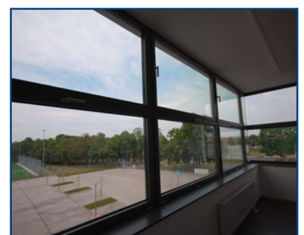
Ausführungsbeispiel: Erdgas Sportpark, Halle / Saale
