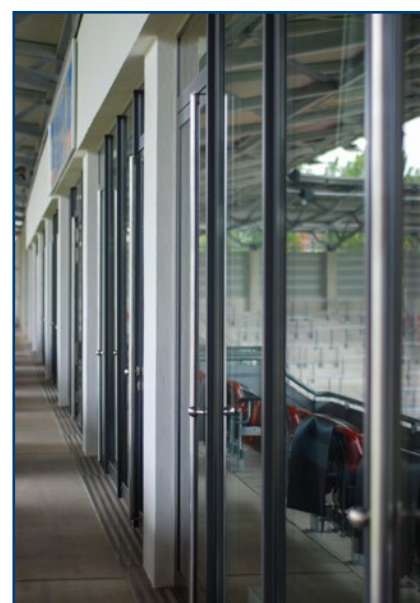
Ausführungsbeispiel: Erdgas Sportpark, Halle / Saale
